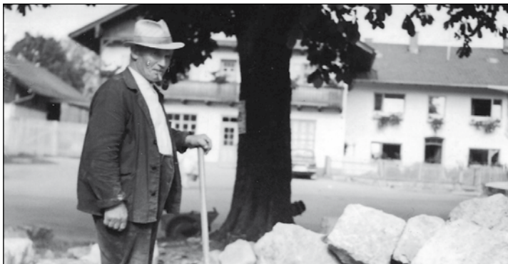
Der Singer Edi, schon Rentner, beim Bau einer Steinmauer aus Tuffsteinen, die beim Abbruch des alten Postwirtgebäudes anfielen.
