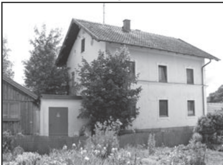
Ob das Trafohäuschen direkt hinter dem Armenhaus bestehen bleibt, entscheidet sich demnächst mit dem Verkauf. Foto: sk
